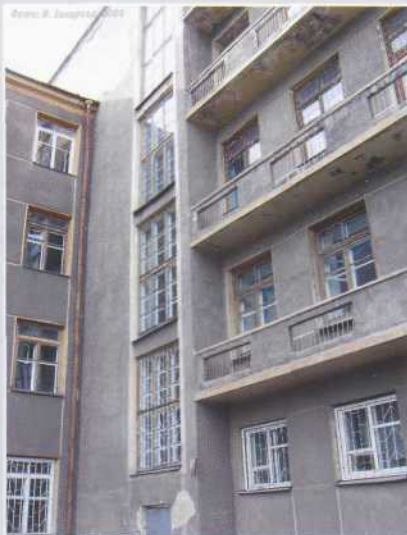
▲ Фрагмент главного фасада
